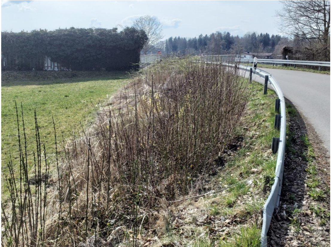
Abbildung 9: Blick in Richtung der Autobahnüberführung © PV München 03/2026
