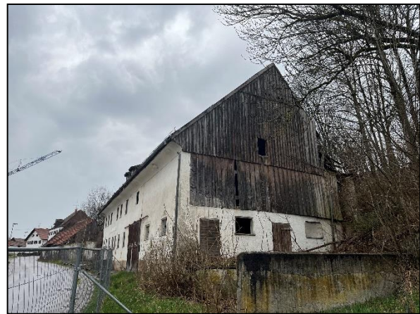
Bild 02: Nordostfassade mit potenziellen Spaltquartiere hinter der Holzverkleidung sowie freiem Einflug in den Dachbodenbereich
