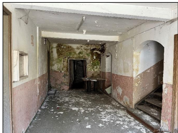
Bild 08: Innenansicht vom Erdgeschoss des Hauptgebäudes mit Zugang zum Lagerkeller
