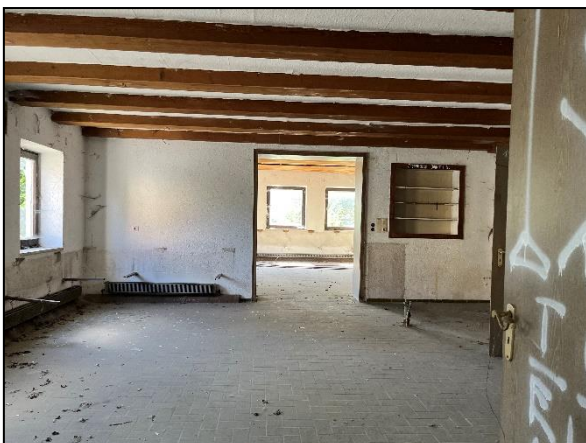
Bild 07: Innenansicht vom Erdgeschoss des Hauptgebäudes
