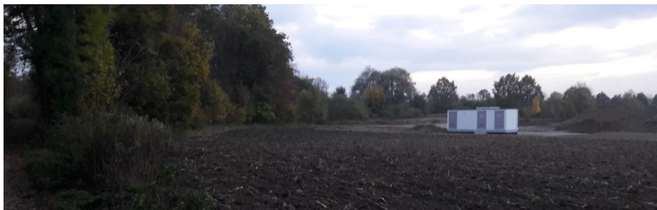
Abb. 3 Transformatorengebäude, errichtet in 2019
