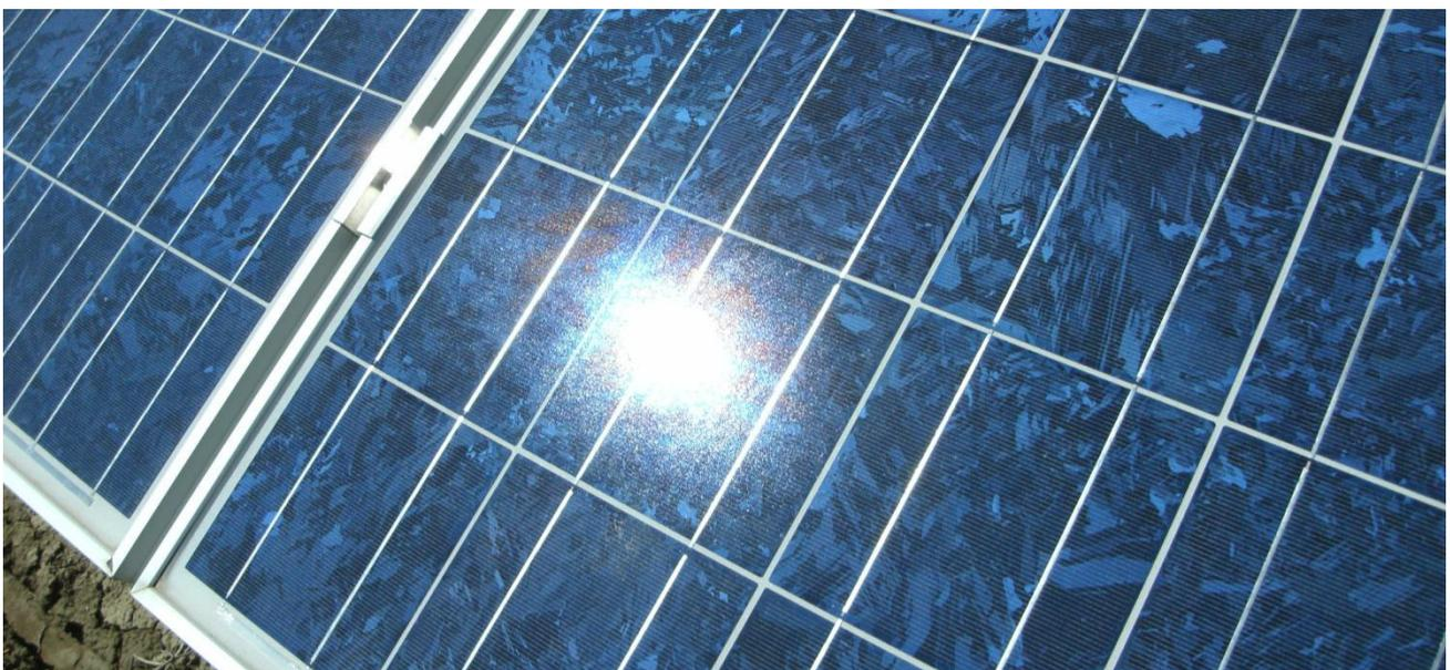
Bild 3.2.2: Diffuse Reflexion von direktem Sonnenlicht (Einstrahlung ca. 980 W/m<sup>2</sup>) auf einem PV Modul (Quelle: SolPEG)
